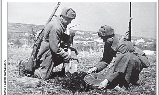
Два советских сапера с немецкой противотанковой миной Tellermine 35 Stahl
